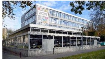
HTS Amsterdam – Hostel, restaurant, werken
