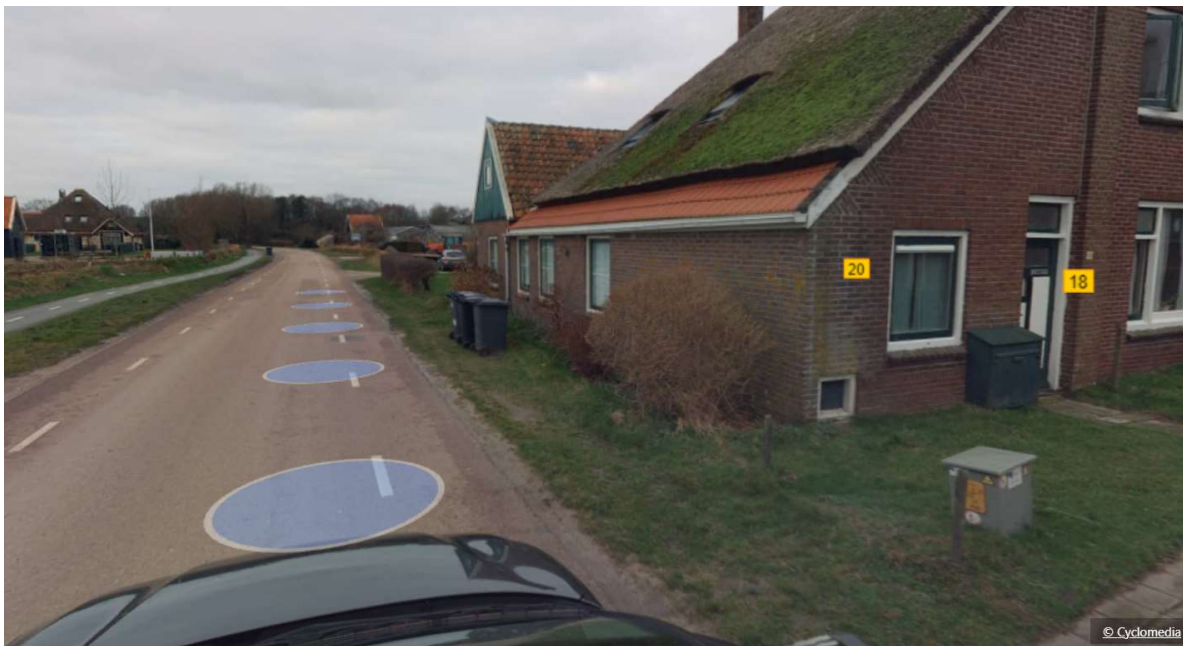
Figuur 2 Ligging rijbaan Rozendijk in relatie tot gevel Rozendijk 20
